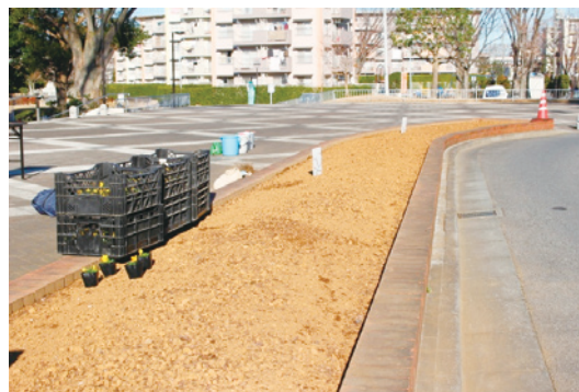
枯れた植栽を抜き取り、土の入れ替えを行った (UR都市機構にて実施)
